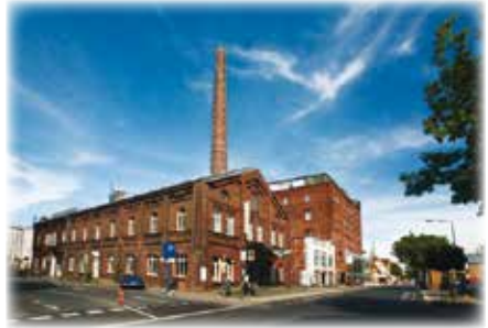
Dienstgebäude | Massener Straße 35
