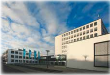
Kreishaus Unna | Friedrich-Ebert-Straße 17
